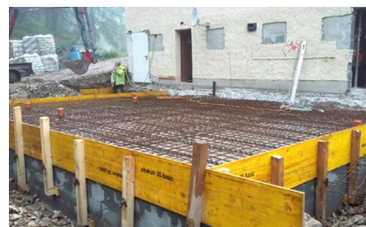
Alpiner Bau – DAV-Schutzhütte Friesenberghaus, liegt auf 2498 m Seehöhe im Zillertal
