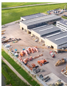
Das neue Firmenareal der KAPL BAU GmbH
