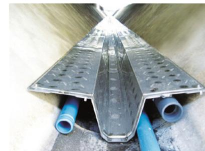
**oben:** Innovative Wärmetauscher, mit denen die Energie aus dem Kanal zum Heizen und Kühlen von Gebäuden geholt wird.
