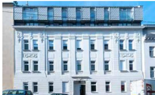
Das zweite prämierte Projekt in der Rautenstrauchgasse 4 wurde heuer im Frühjahr vom Bauleiter Klaus Schroeder an den Bauherren übergeben. Der Umbau bestand aus einem Teilabbruch, dem Aufzugseinbau und einer Aufstockung mit Dachgeschoßausbau. Im Innenhof wurde ein Wärmedämmverbundsystem hergestellt, die straßenseitige Stuckfassade fachmännisch instandgesetzt.
